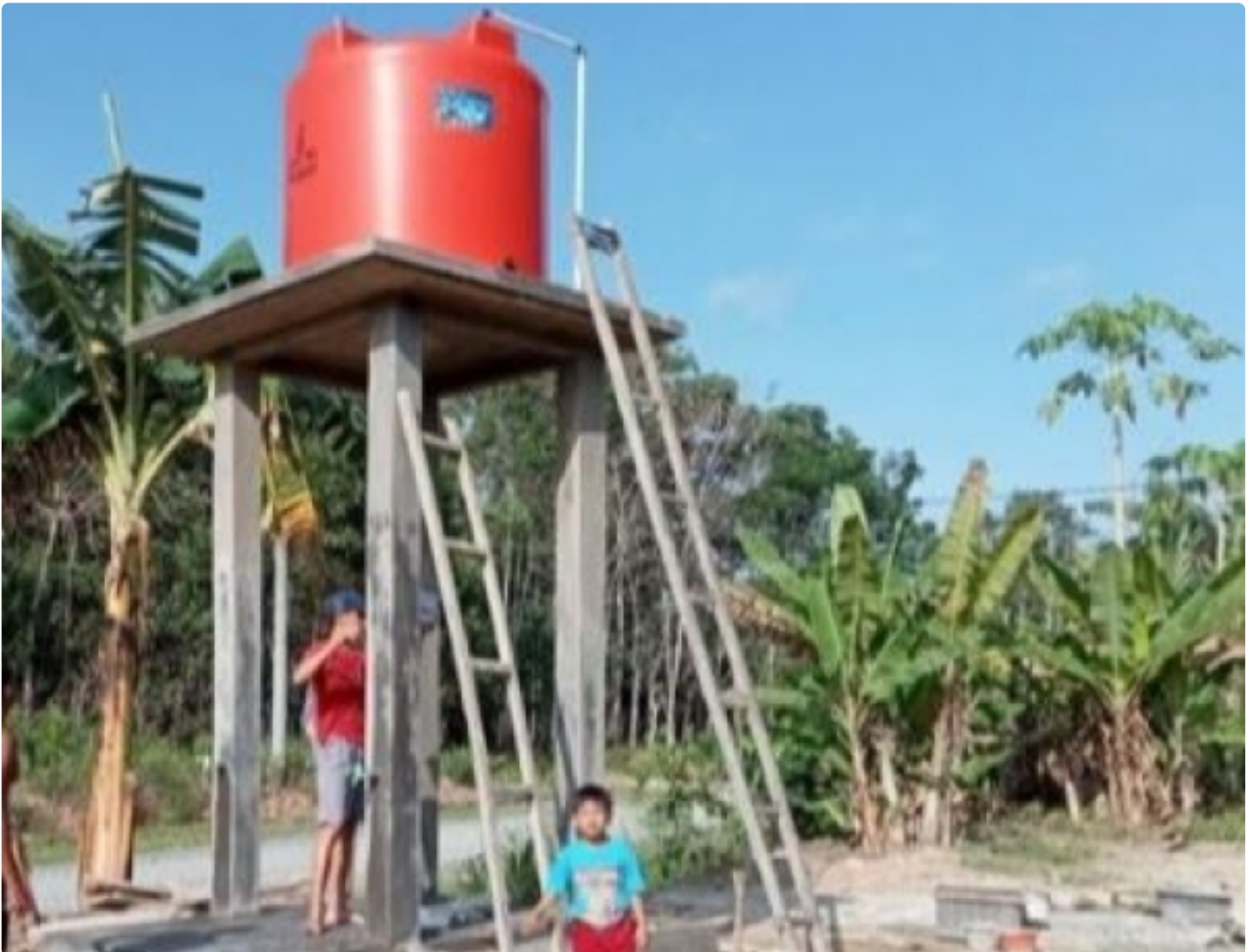
Pembangunan sumur bor di Desa Fajar Baru
